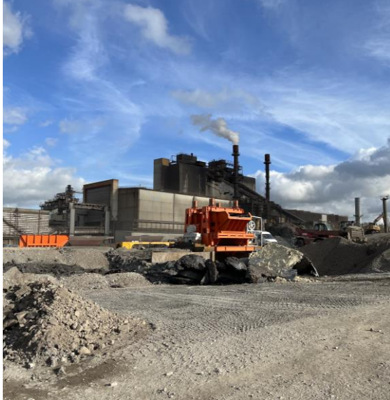
Außenbereich des Stahlwerks, Hot Box Move, Hot Box und die Kippvorrichtung
